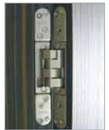
Detail skrytého pantu
