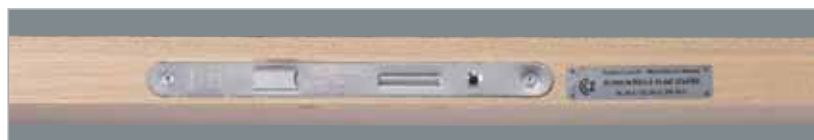
Označení dveří protipožárních dveří u zámku
